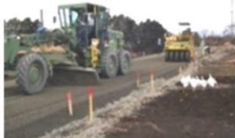
丁張りによる施工
