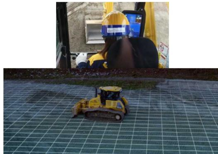
ICT建機による施工
